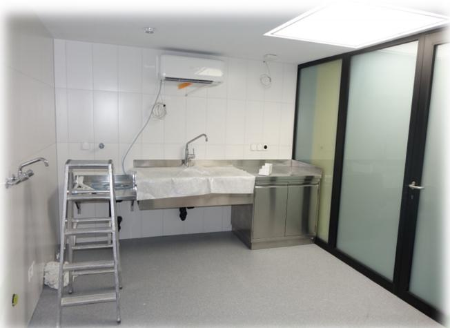
In der Rüstküche sind die Rückwände geplättelt, die Gipserausbesserungen an den Wänden gemacht und es wurde teils neu tapeziert und gestrichen. Die Chromnickelstahlmöbel aus der bestehenden Küche sind verschoben und ein neuer Bodenbelag ist eingebaut. Die Rüstküche kann somit bis Ende April in Betrieb gehen. Das Lager im Untergeschoss wurde ebenfalls soweit vorbereitet, damit es anfangs Mai genutzt werden kann.
