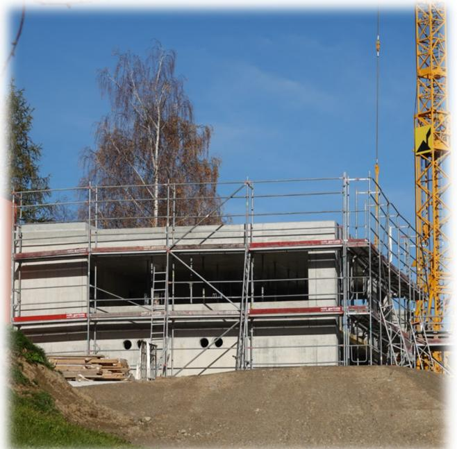
Das Ende der Baumeisterarbeiten bedeutet für die Installateure gleichzeitig der Start für die Rohinstallationen. Der Fokus liegt vor allem auf den WC-Räumen und den Wandschlitz für die Folgearbeiten. Ab anfangs Dezember sind bereits die weiteren Gewerke im Einsatz; der Gipser mit dem Grundputz an den Wänden, der Einbau vom Unterlagsboden, die Flachdacharbeiten und, je nach Temperatur-/ und Witterungsverhältnissen, die Fassadenarbeiten.
